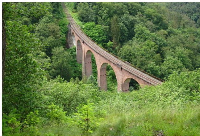
Der Viadukt und viele Fingerhüte
